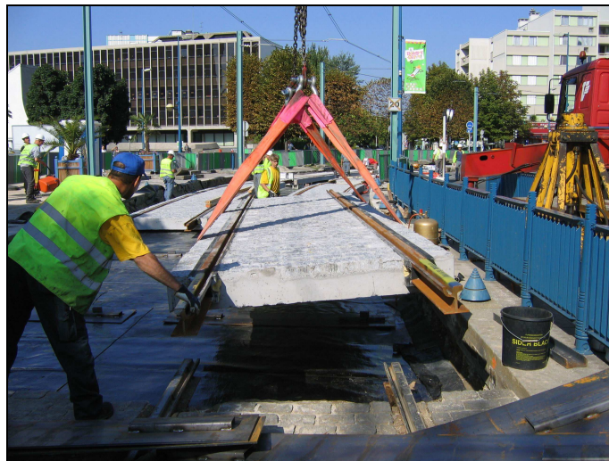
Figura 20. Ejemplo de quinta generación de Carril Embebido
