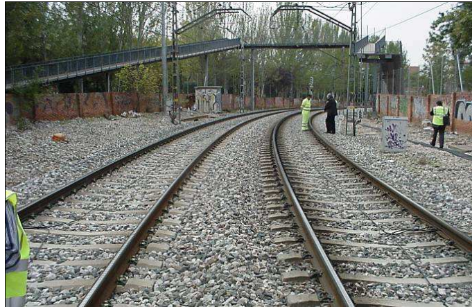
Figura 7. Vía sobre balasto
