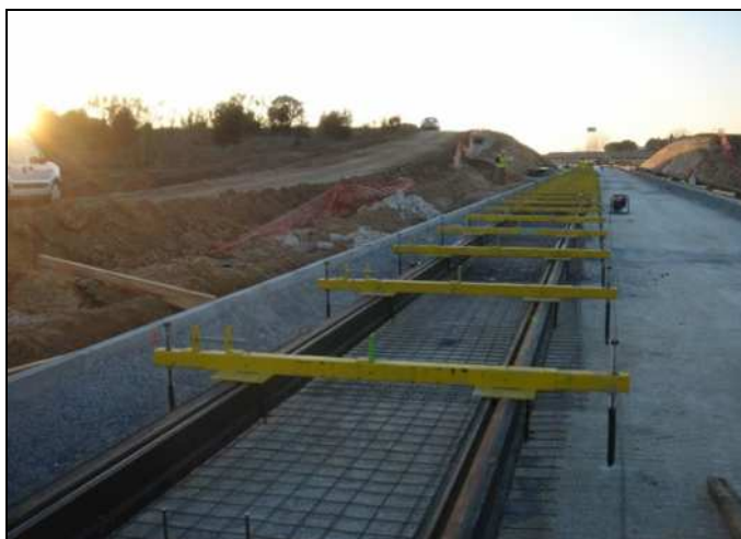
Figura 17. Sistema de apeo-guías que fijan la posición final del carril en las sus tres coordenadas (técnica “top-down”)
