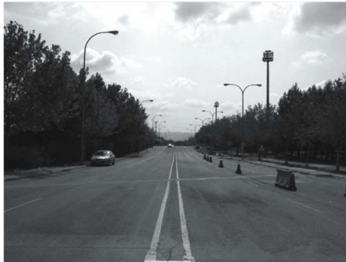
Estado actual Vía de Circunvalación
