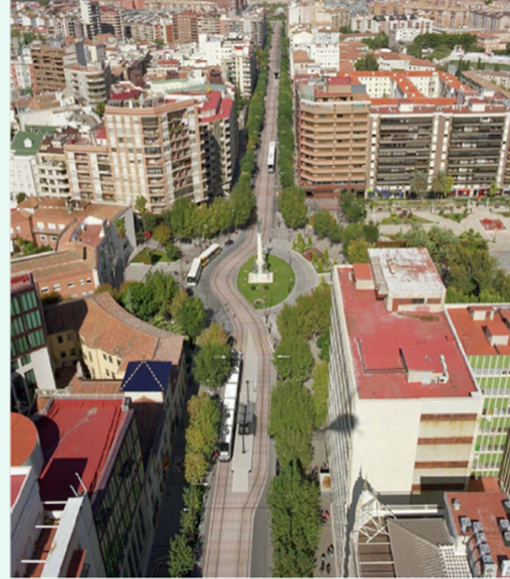
Vista del Paseo de la Estación dirección Norte con plataforma tranviaria
