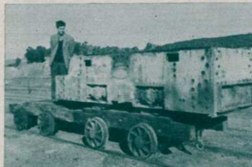
Ferrocarril de Tharsis. Locomotora eléctrica, sobre un vagón plataforma, para servicio interior en la mina de La Zarza
