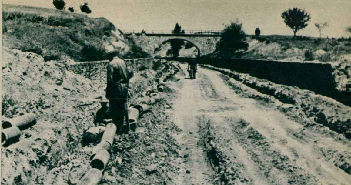
Saneamiento de trincheras en las obras del ferrocarril Madrid-Burgos.
