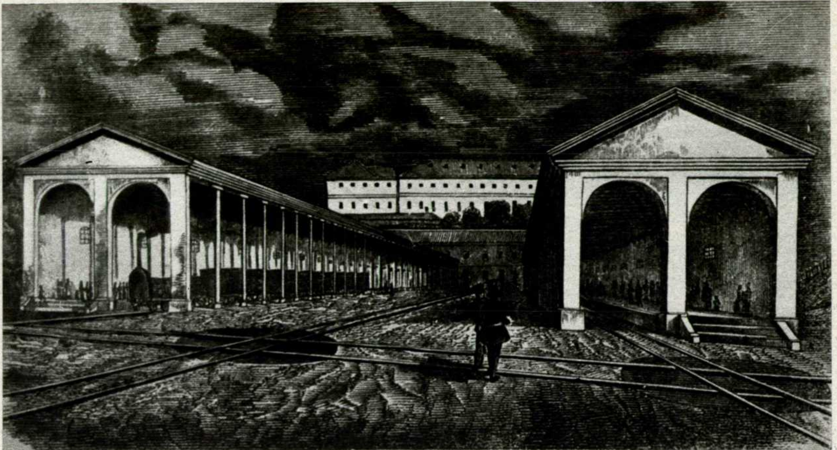
Embarcadero del ferrocarril de Madrid a Aranjuez, puesto en servicio el 10 de febrero de 1851.
