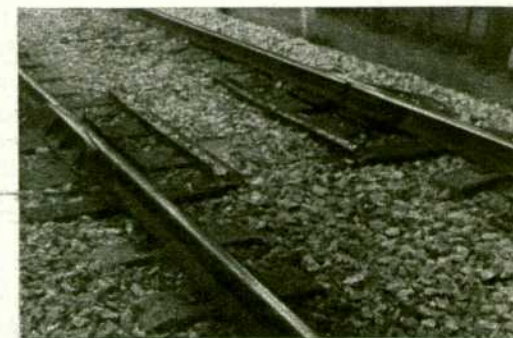
Junta de dilatación.
