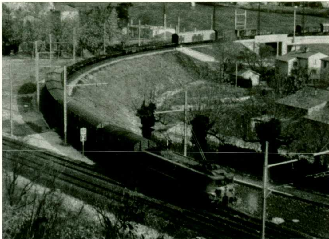
Tres enlaces entre las líneas electrificadas de ambas márgenes del Ródano permiten afrontar los incrementos de tráfico del Sudeste francés.
