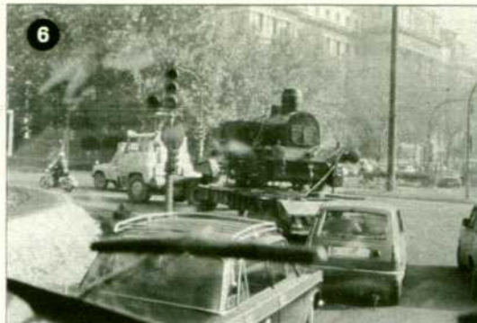
6 Desde la cabina de la grúa decimos adiós a la primitiva historia del vapor. Como decorado, fuente de agua y edificio de Fomento, hoy de Agricultura.
