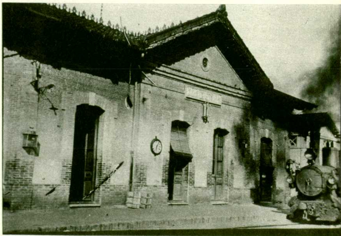
Aspecto de la estación de Llagostera, en 1954.
