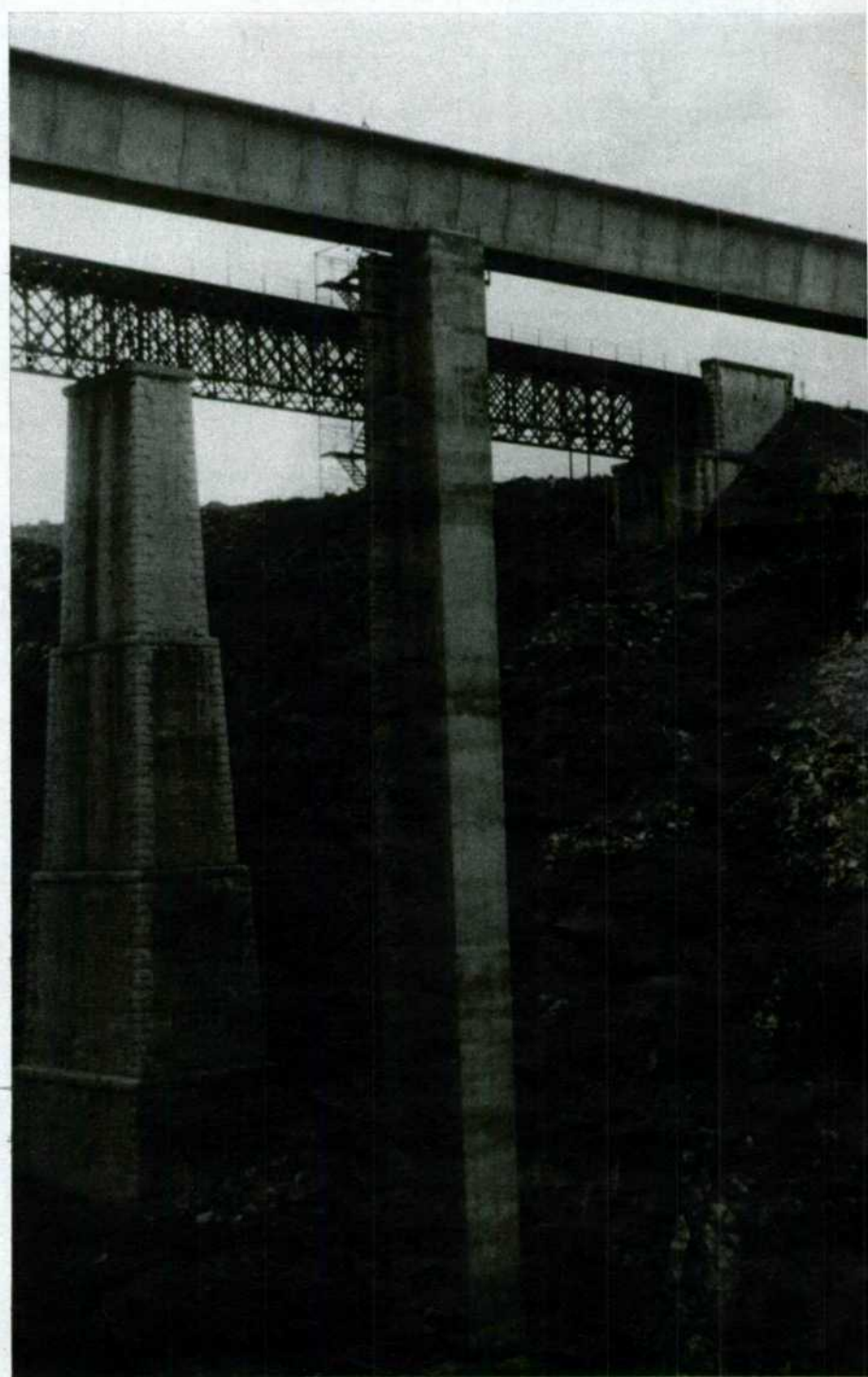
El puente nuevo va cobrando forma y se "codea" con el preexistente.
