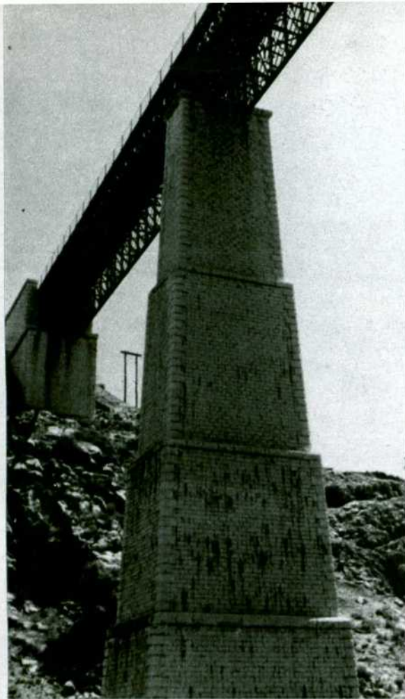
Vista en "contrapicado" del puente antiguo, ahora fuera de servicio.
