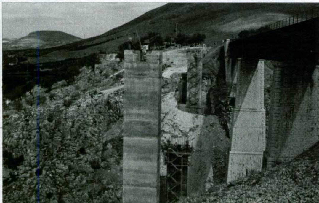
Perspectiva de las obras: el nuevo y el viejo, en paralelo.
