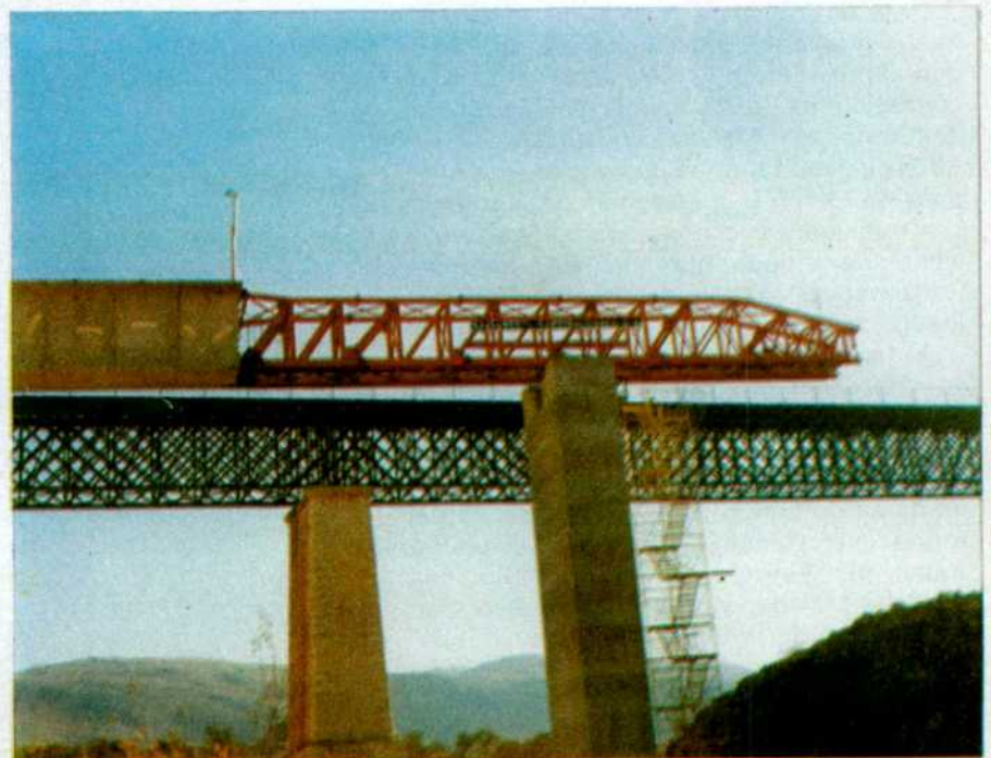
Diversas fases de la operación de lanzamiento, en las que se observa el pescante deslizándose por las pilas.
