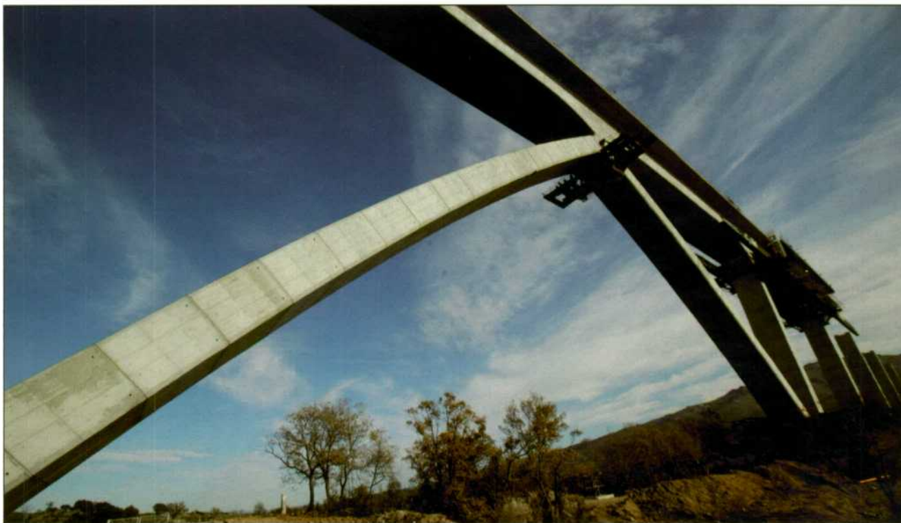
Construcción del espectacular viaducto de Arroyo del Valle.
